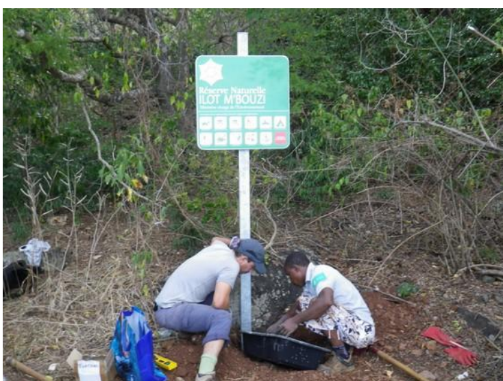
Ancrage des panneaux
